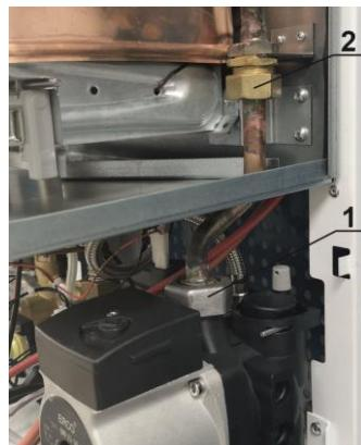
Рис. 20. Демонтаж трубы насоса
