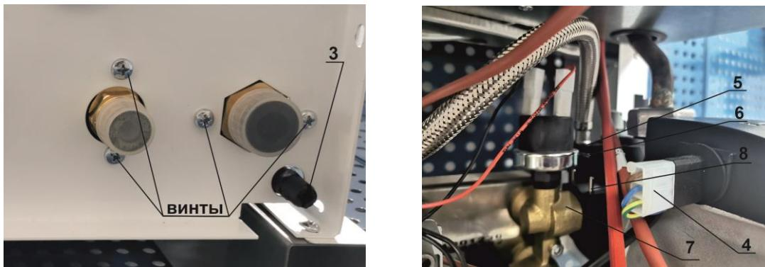
Рис. 21. Демонтаж насоса
