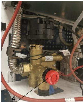
Рис. 25. Демонтаж предохранительного клапана
